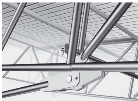
Łączenie ściągu
