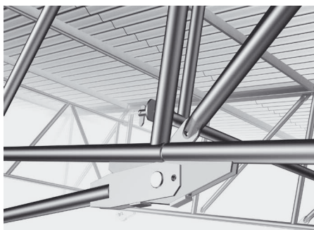
Łączenie ściągu
