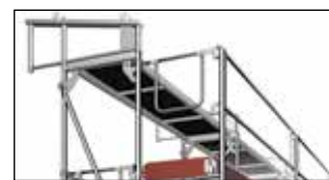
Poręczne ochronne na ostatnim poziomie, bezpieczny montaż dzięki tymczasowemu pomostowi na konsolach
